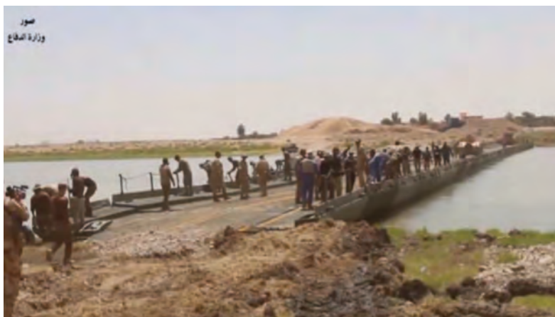
Pont flottant de l'armée Irakienne sur le Tigre à Mossoul (vue depuis la rive Est)
