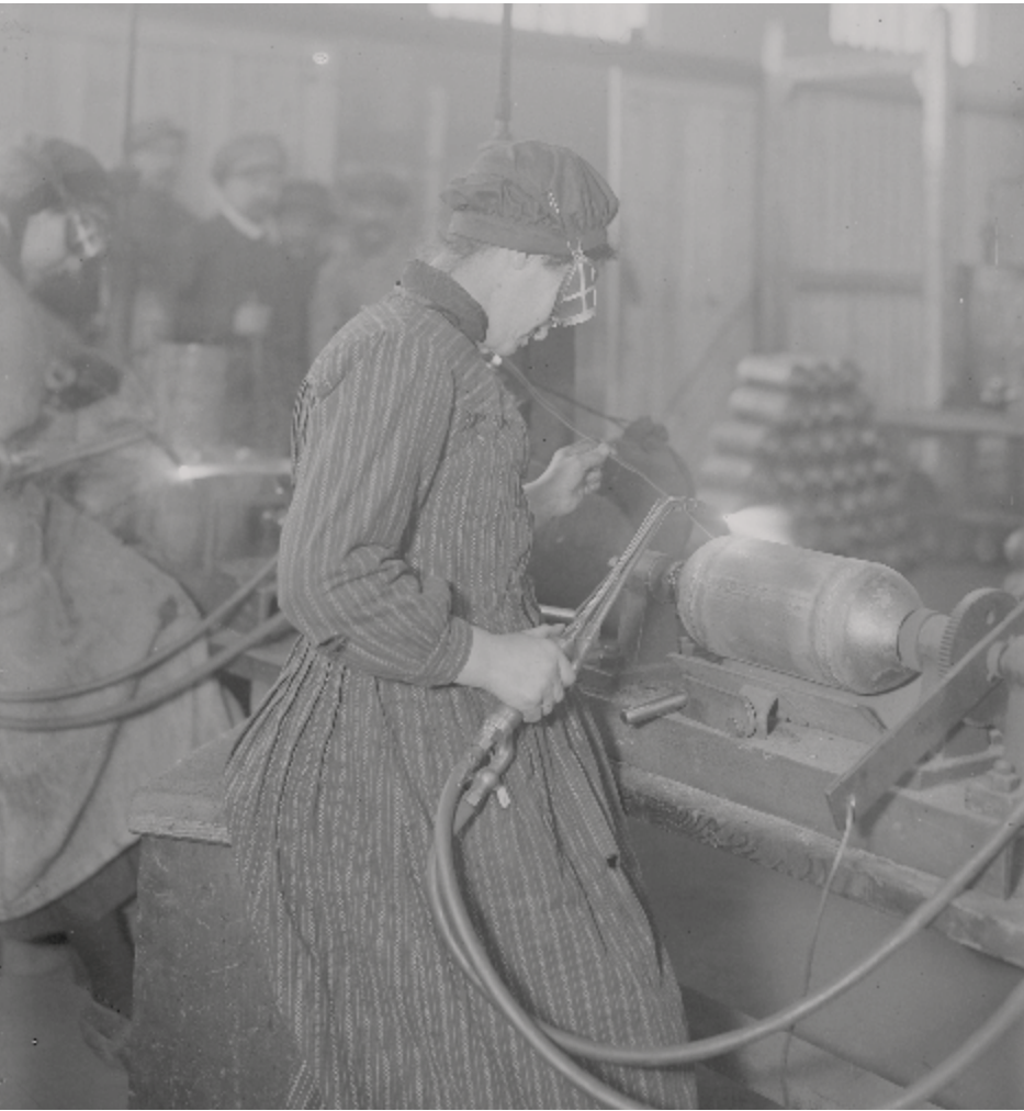
Forges de la Chaléassière (Saint-Étienne). Fabrique de bombes de 58 mm. Finissage de la calotte.
